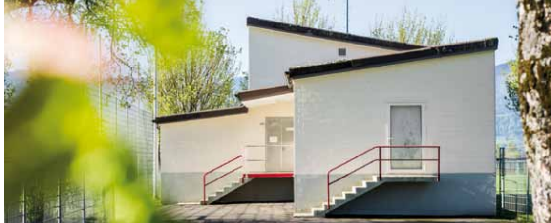
bestehendes Pumpwerk Grünfeld
